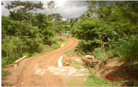
Malas condiciones de los caminos entre el Cruce de Trinidad y Aguacate Arriba.
