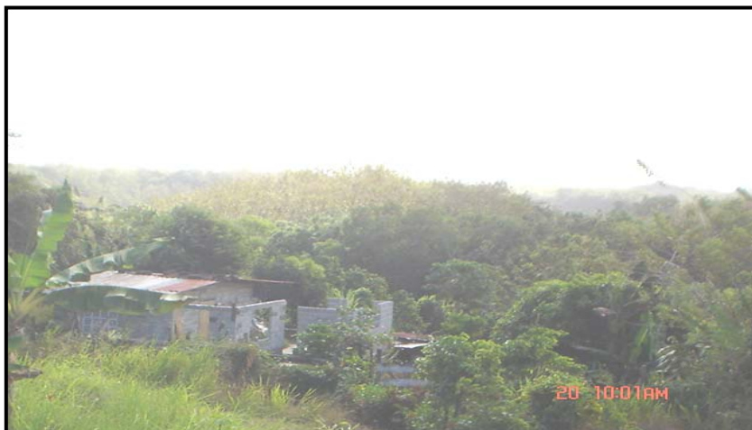
Estado de una vivienda en el sector de Villa de los Ángeles
