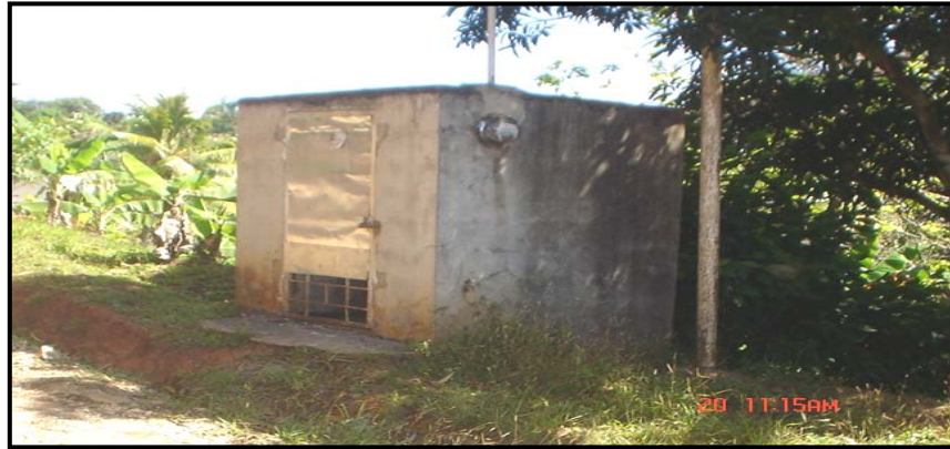
Estructura para la bomba de agua en el sector de La Torre
