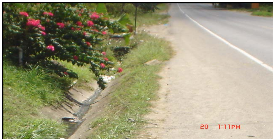
Desagüe pluvial a orillas de la carretera de Juan Demóstenes Arosemena
