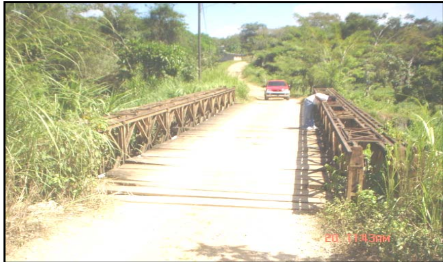
Puente en el sector de Limoncito
