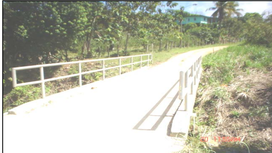
Puente en el sector de Limoncito
