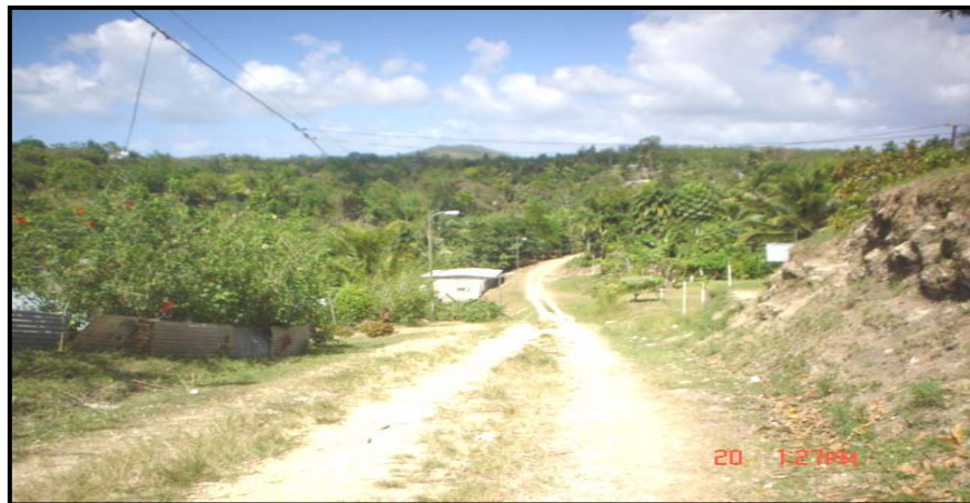
Vía de acceso en el tramo alto de la subcuenca de río Limón
