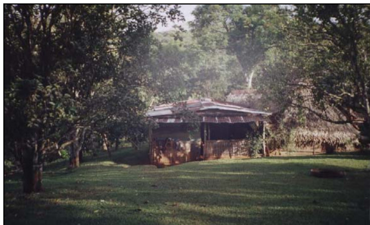
Características de algunas viviendas con perfiles rurales
