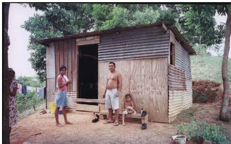
Vivienda en muy precaria condición en la comunidad de Aguas Claras
