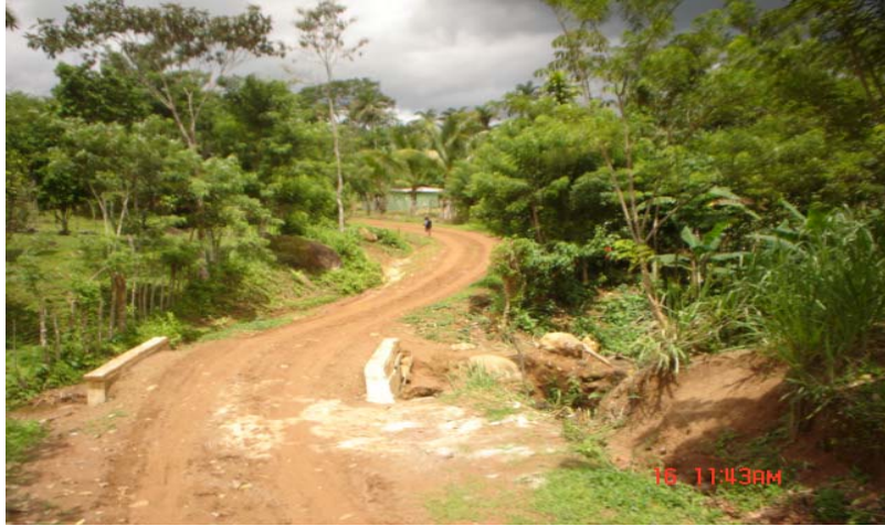
Condición del camino entre el cruce de Trinidad y Aguacate Arriba
