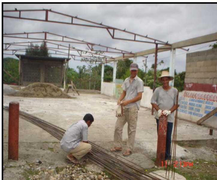
Reparación de la casa comunal de Villa Unida
