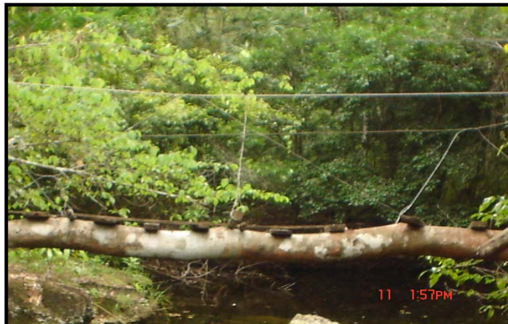
Puente rural que facilita el paso de la quebrada La Concha
