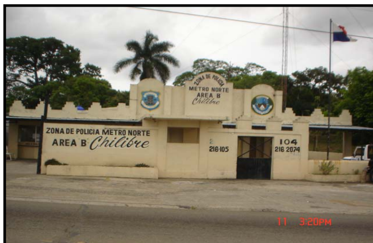
Subestación de policía en Chilibre Centro
