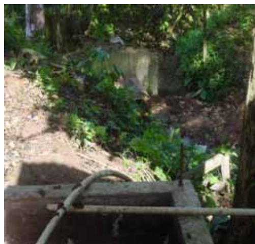
Fotografía No 5 Tina de Oxidación de los desechos sólidos. Honda Arriba. Coordinadas: N 08°52.967'; W 080°01.935'
