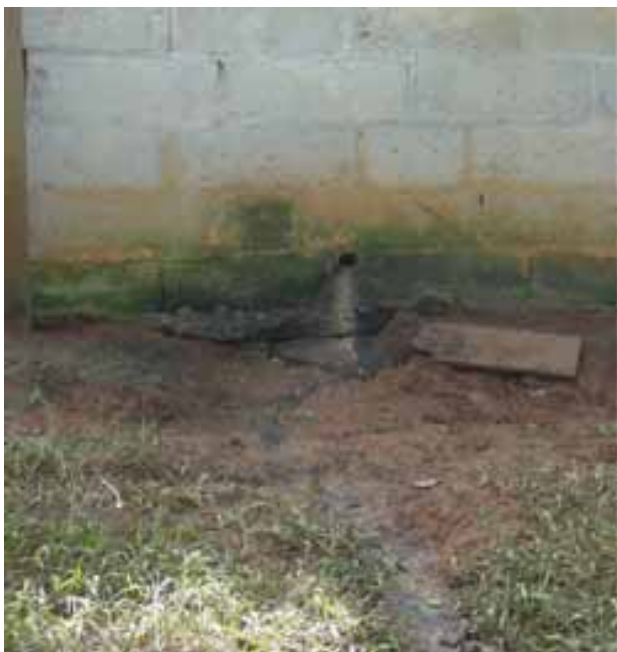
Fotografía No. 6 Desagüe de desechos de las porquerizas, los Faldares. Coordinados: N 08°53.971 'W 080°03.019.
