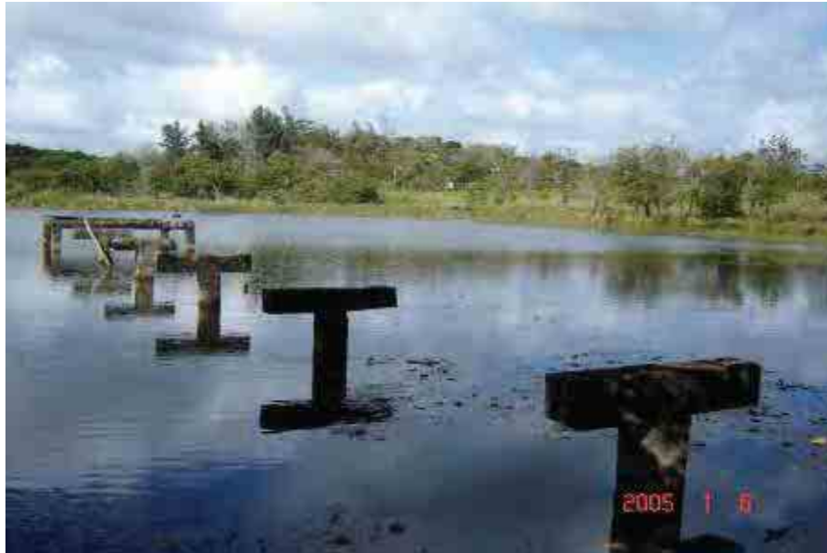
Fig. 3 Infraestructuras anteriormente utilizadas para soporte de muelle
