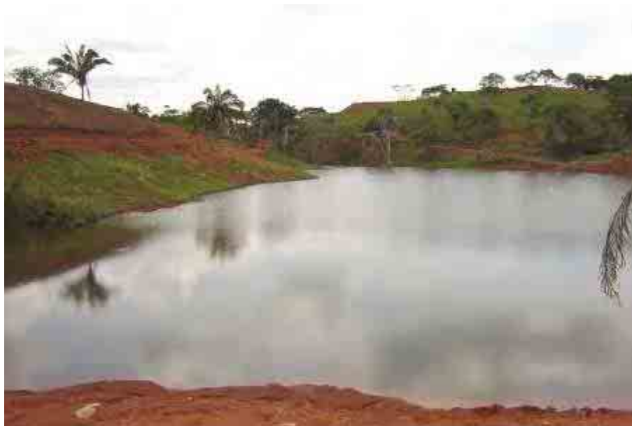
Fig. 2. Vista del reservorio Villa Gina
