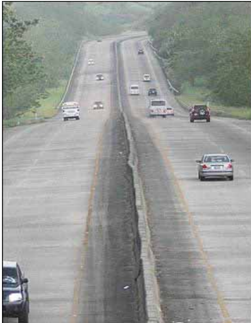
El tramo de Tinajitas a Chilibre de la autopista Panamá-Colón es muy utilizado por buses, transportes de carga y carros particulares
