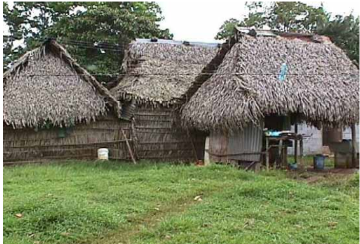
Tipo de vivienda predominante en las comunidades del sector oeste del Canal, las cuales se encuentran entre las más pobres de toda la CHCP
