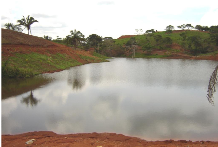
Fig. 2. Vista del reservorio Villa Gina
