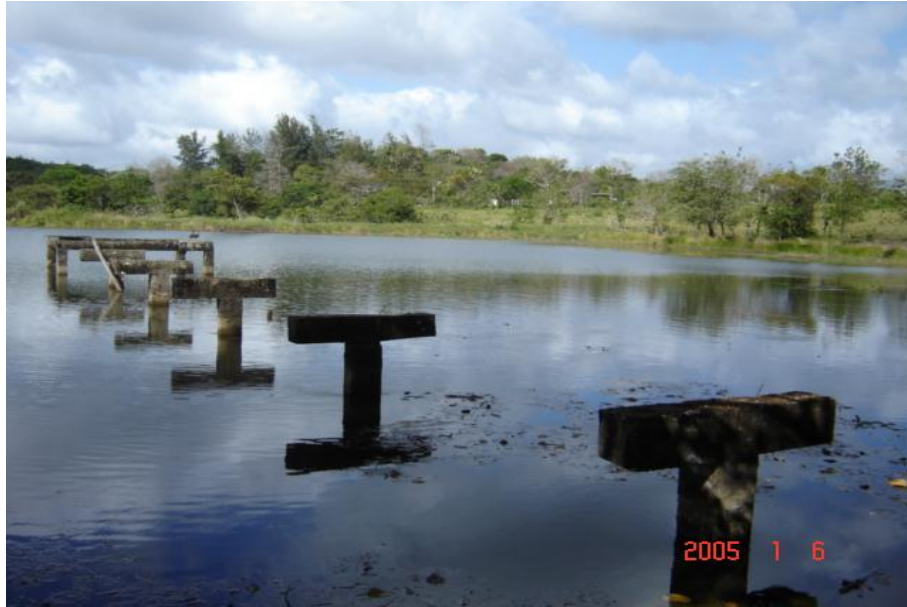
Fig. 3 Infraestructuras anteriormente utilizadas para soporte de muelle
