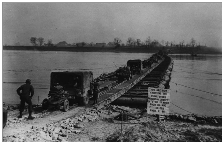
Figura 62: Puente flotante estadounidense del la Segunda Guerra Mundial en Alemania, similar al tipo construido para cruzar el Río Chagres y quitado después de 1945.
