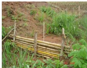
Construcción de acequias y Barreras Muertas
