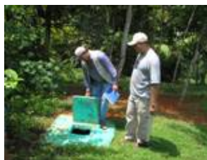
Fosa de soterramiento para desechos sólidos
