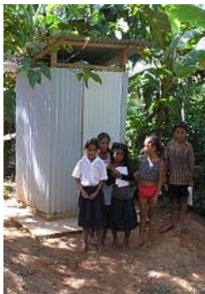
Letrina ventilada construida por el proyecto
