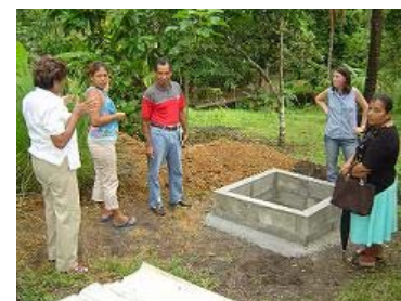
Dirección técnica en construcción de fosa de soterramiento
