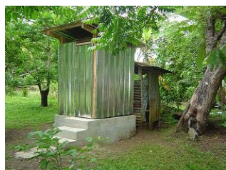
Letrina mejorada construida por el proyecto
