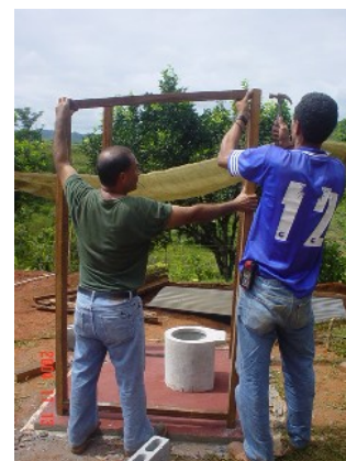
Construcción de modelos de letrina y estufas mejoradas.
