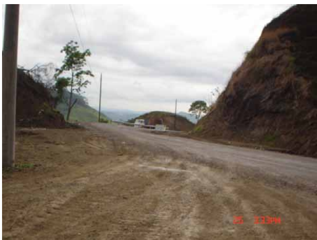
El poco mantenimiento de los caminos dificulta el acceso hacia los sectores rurales de algunas comunidades
