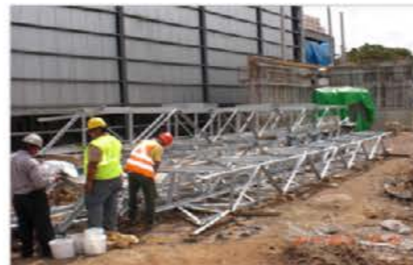
Inicio de los trabajos de instalación de la estructura que soportaría los nuevos equipos en la Subestación Eléctrica de Miraflores [Noviembre 2012]
