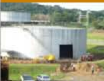
Se inició el proceso de dismantelamiento
