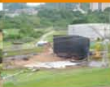
Se lo dismanteló la superficie y se cobertó tierra con en su ubicación
